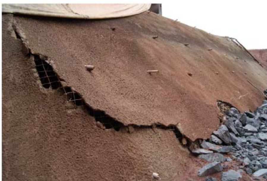
Figura 2.4 - Pé do talude direito junto ao emboque, após deslizamento lento do revestimento.
