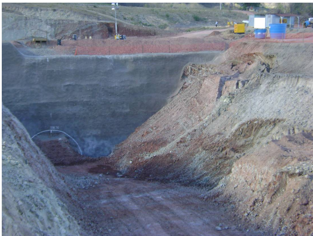
Figura 2.1 – Talude lateral instável próximo ao emboque do Túnel Cuncas I.
