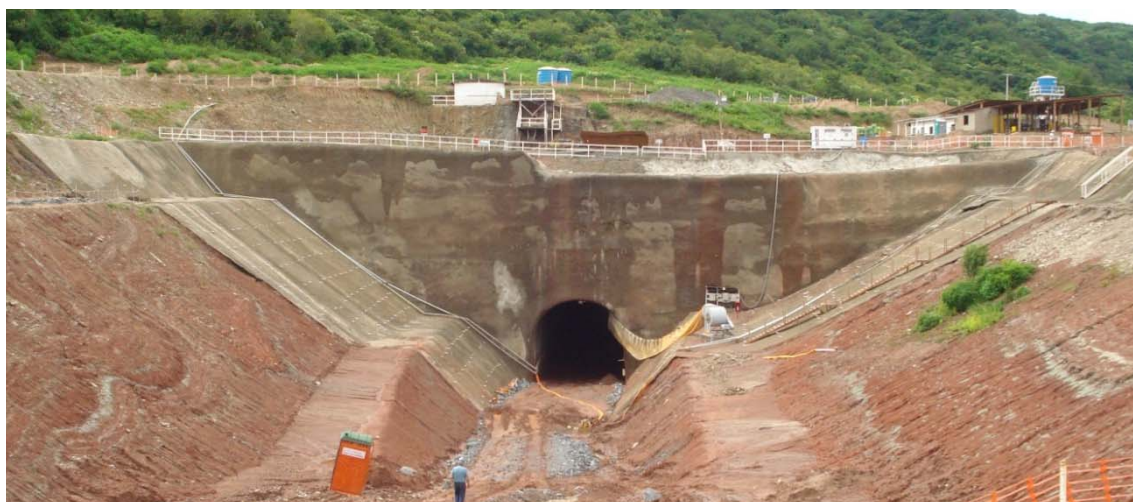
Figura 2.3 - Taludes do canal revestido com concreto projetado.
